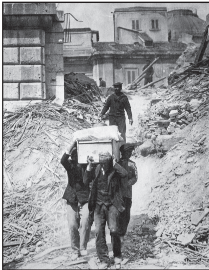
Terremoto di Messina del 1908
