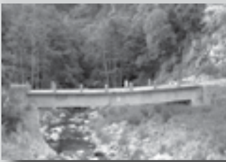
Ponte sul fiume Lese
