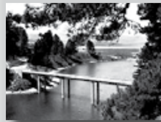
Ponte sul Cecita
