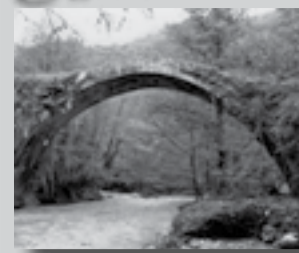
Ponte sul fiume Savuto
