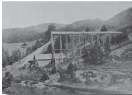
Segheria ad acqua di Vutturino
