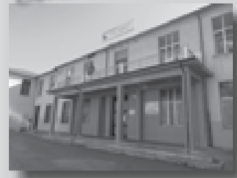
Scuola elementare "Dante Alighieri"
