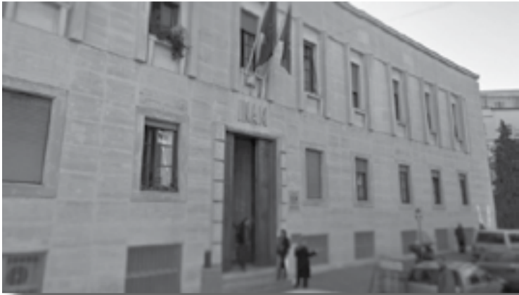
Sede dell'Azienda Sanitaria Provinciale di Cosenza
