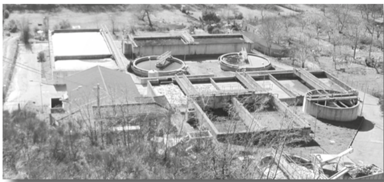
Veduta aerea del depuratore di Ponte Arvo
