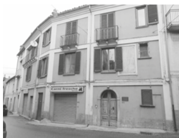
Lapide posta sulla facciata ex Cassa Rurale
