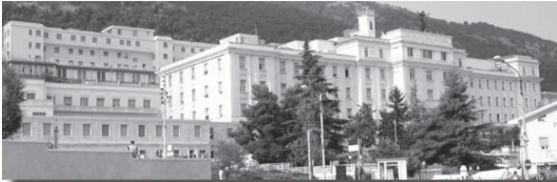
Casa Sollievo della Sofferenza - San Giovanni Rotondo
