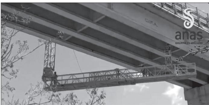
Un controllo accurato dello stato di salute del viadotto "Neto 1" della superstrada Silana-Crotonese, è stato effettuato a cura dell'Anas, martedì 11 aprile, utilizzando la navicella "by-bridge" che disponendo di un braccio a rotazione ha consentito ai tecnici-ispettori di agire sospesi nel vuoto, al di fuori della sede stradale e senza l'ausilio di ulteriori apparecchiature,
