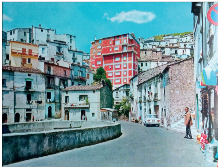
Corso Umberto, attuale via XXV Aprile con sullo sfondo Palazzo Sant'Antonio
