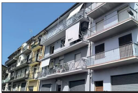
FUGA DI GAS
